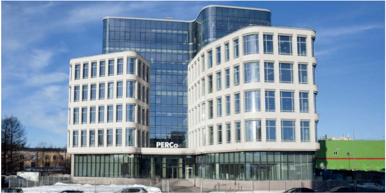
Главный офис PERCo
